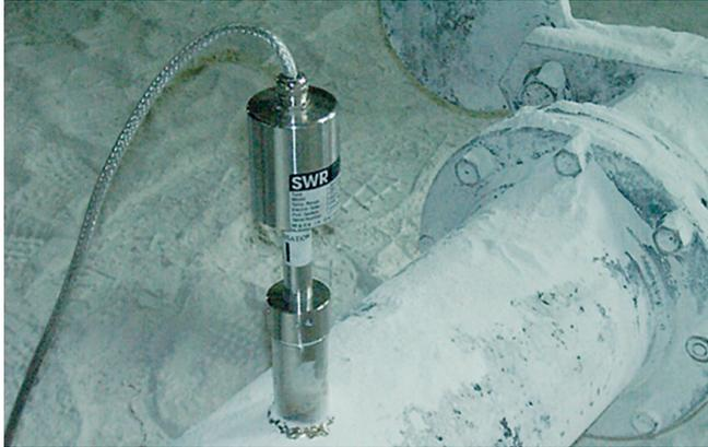
SolidFlow 2.0 zeichnet sich durch seinen unkomplizierten und verschleißfreien Einbau aus.
